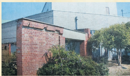
宇部紡績工場の赤れんがが組み込まれた図書館の壁面
